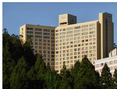
越後湯沢のリゾートマンション
